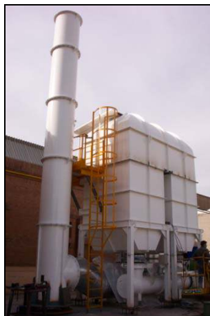
Termoreactor: equipo de depuración de emisiones de COV's por oxidación térmica regenerativa.
